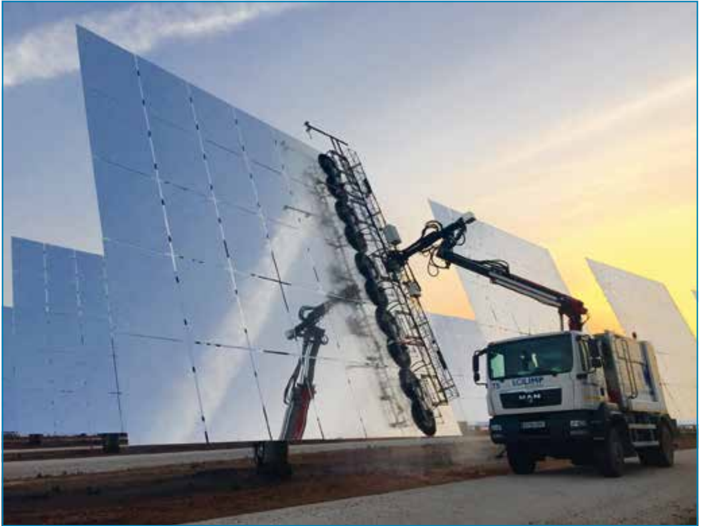
GEMASOLAR-Anlage der Torresol Energy, in der Reinigungstechnologie von ECILIMP eingesetzt wird. © SENER
